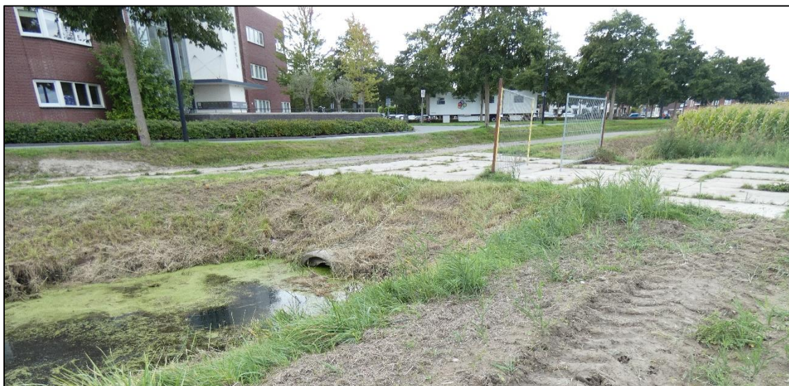
Figuur 4: De toegangsweg aan de Joost van Den Vondellaan.
