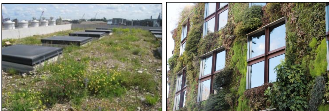
Figuur 21: Bruin dak (links bron: checklist groen bouwen) en groene gevel (rechts bron: groenkennisnet.nl).
