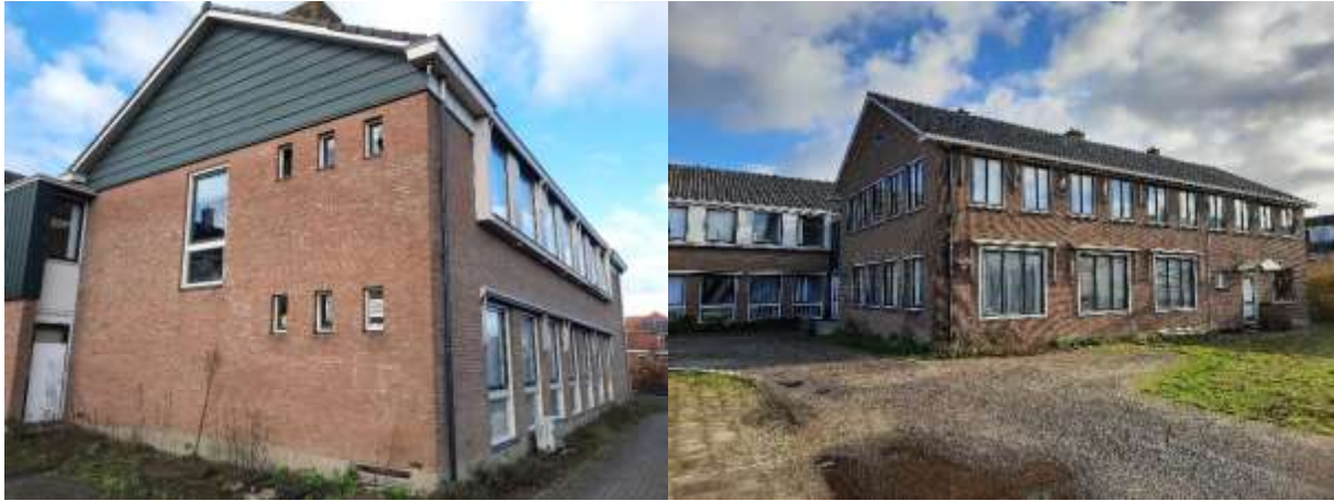
Detailopname van de te slopen bebouwing.
