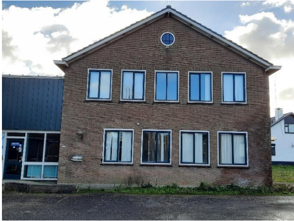
Gierzwaluwen kunnen gevelpannen en de nokvorst benutten om de holle ruimte onder dakpannen te betreden.
