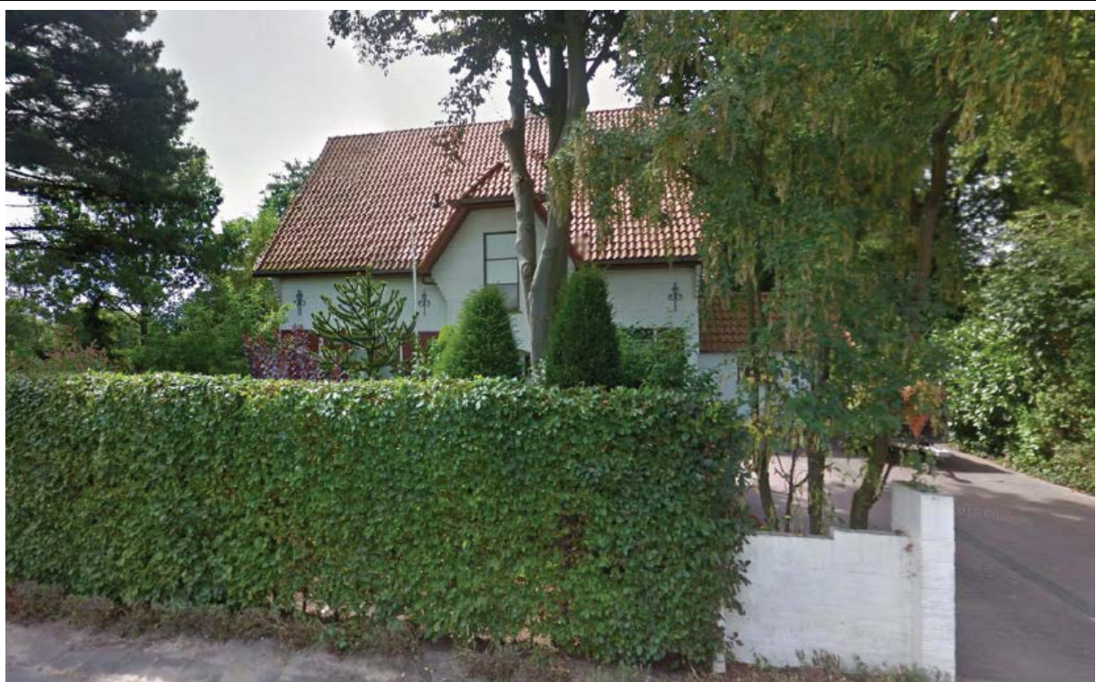
Figuur 4. Bestaande woning
