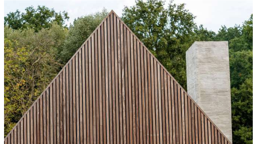
Afbeelding 46 | Houten gevelbekleding met gemetselde schoorsteen.
