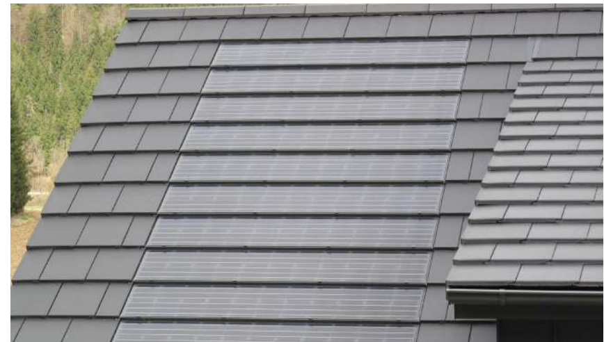
Afbeelding 47 | leipannen met geïntegreerde zonnepanelen in een geordend patroon.
