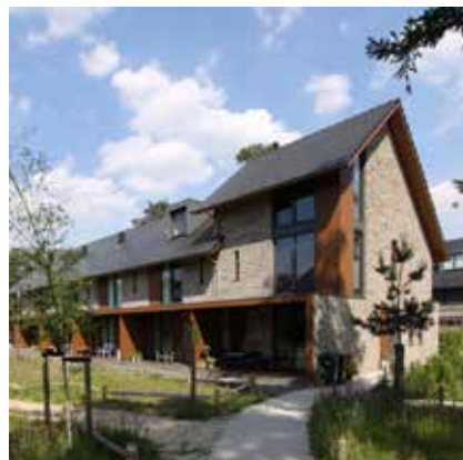
Terassen en dakenspel
