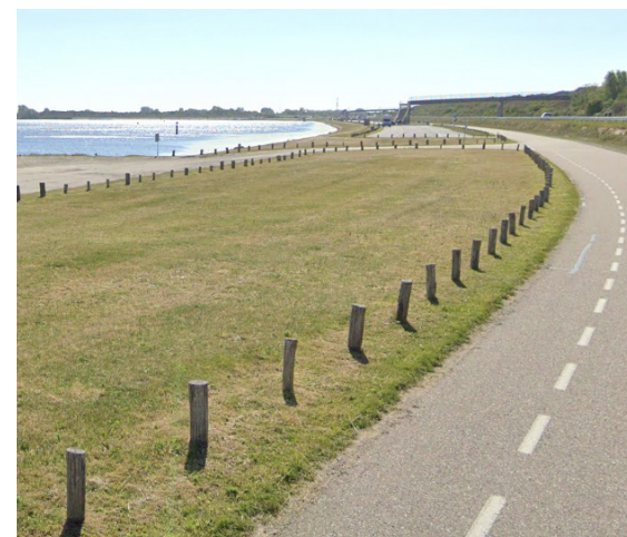
Paaltjes langs de rijbaan voorkomen parkeren in de berm, paaltjes van hout afkomstig uit het projectgebied
