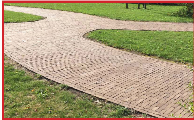
Wandelpaden van gebakken klinkers aan de flanken van de groene wig leiden naar de voordeuren van de woningen
