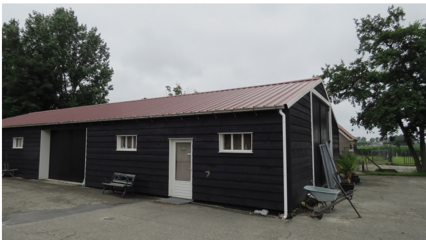
Afbeelding 6: Eén van de te slopen loodsen
