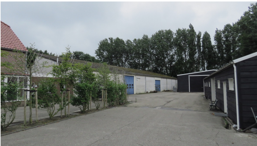
Afbeelding 4: De te slopen loodsen achter de hofstede.
