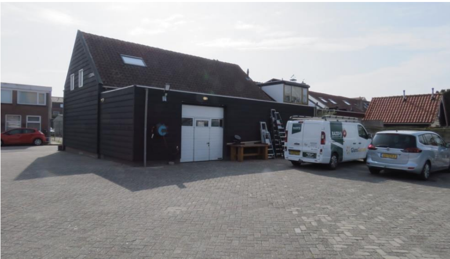
Figuur 2.3: foto achterzijde bestaande bebouwing
