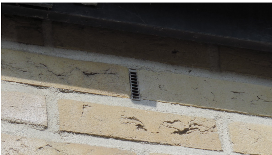
Afbeelding 8: Bijnebekjes in stootvoegen van de St. Elizabethstraat nr. 17 maken de spouwmuur ontoegankelijk voor vleermuizen.
