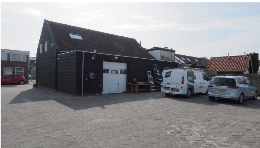
Afbeelding 4: Zicht op de achterzijde van het plangebied.
