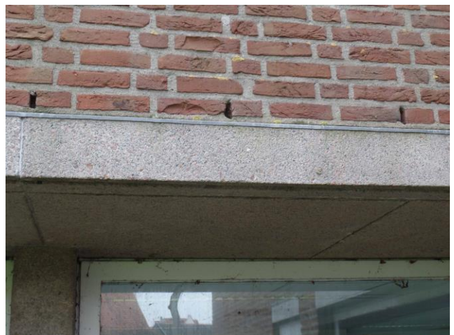
Figuur 10: Open stootvoegen zonder sporen
