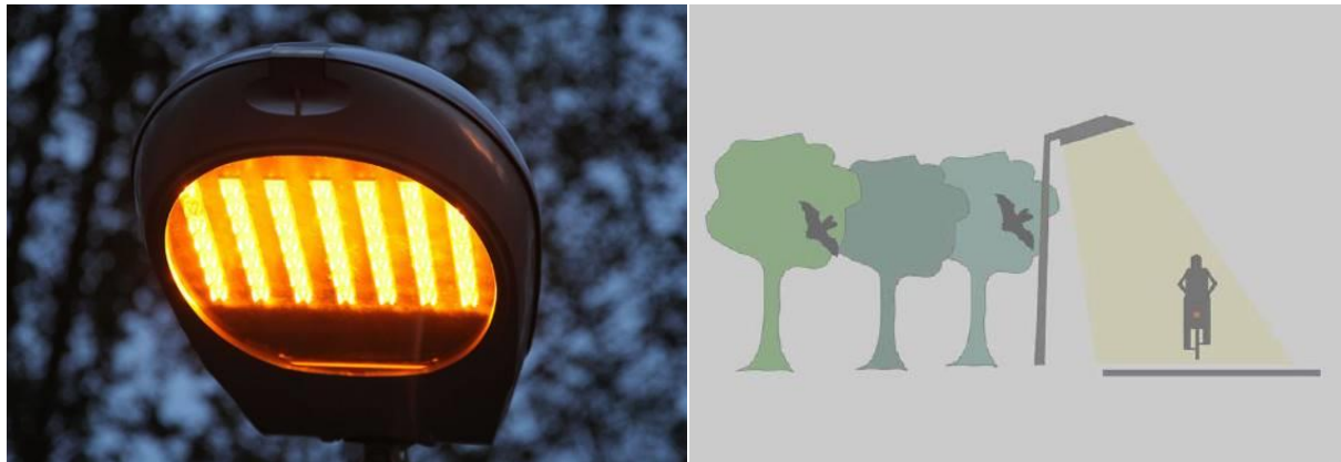
Figuur 6.3. Links: amberkleurige UV-vrije LED-armatuur. Rechts: scherpe afsnede van lichtinval.
