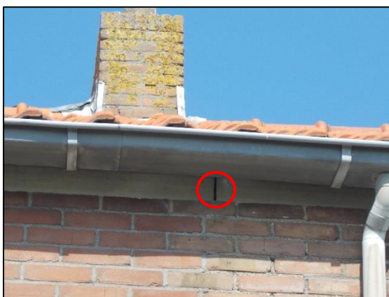
Figuur 8: Vleermuisgeschikte spleet onder dakgoot. Bron: NWC
