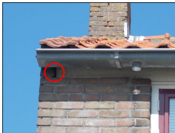
Figuur 9: Vleermuisgeschikte opening onder dakgoot. Bron: NWC
