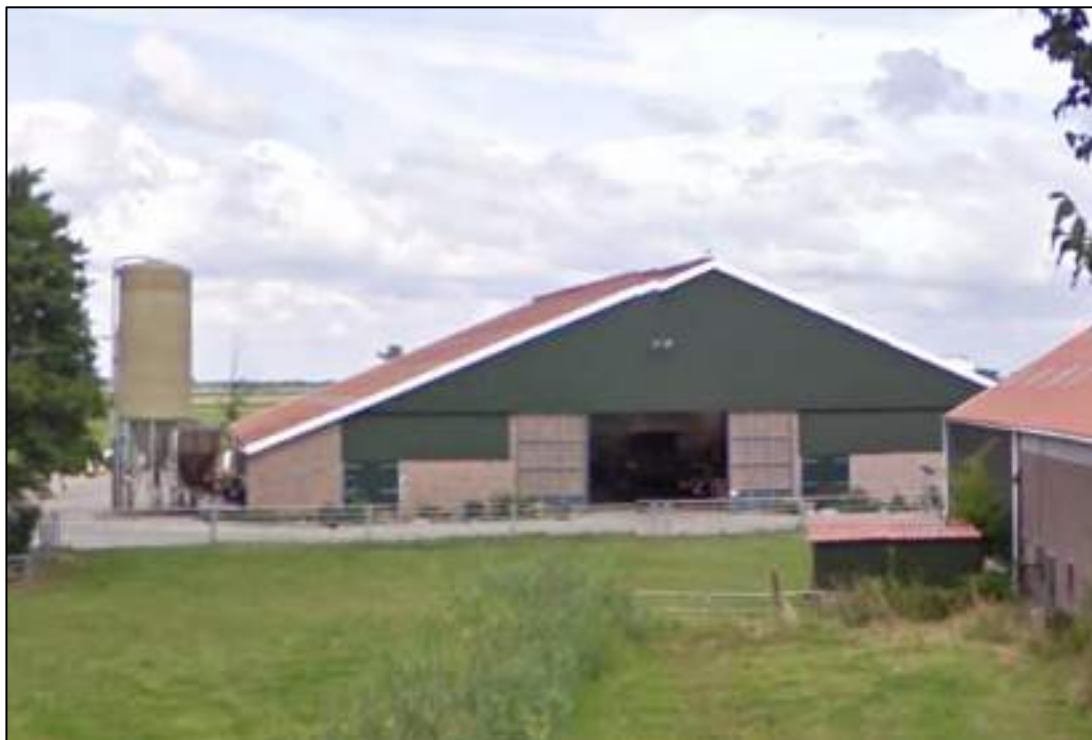
Afbeelding 4.1: De bestaande melkveeststal is in een goede staat.
