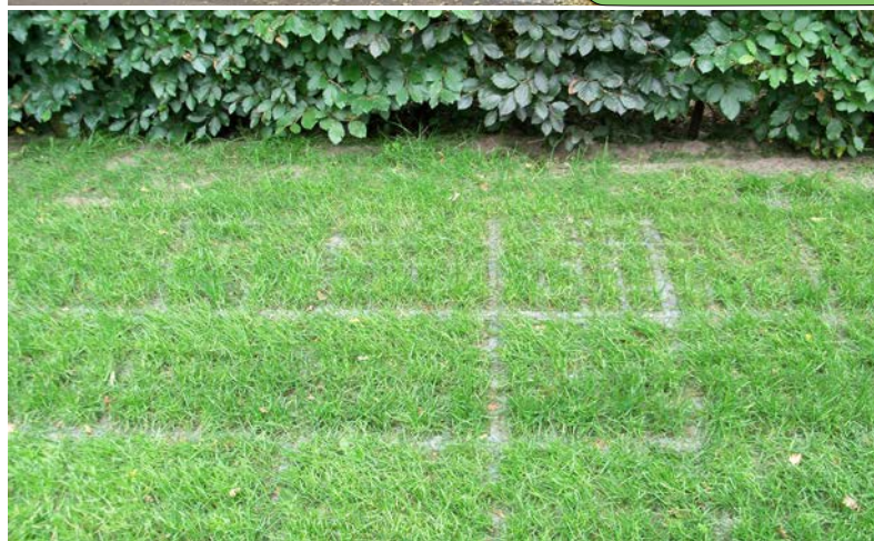
Bermversteviging t.b.v. parkeren in openbare ruimte
