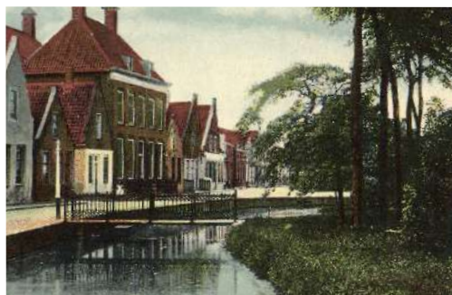
Groene begeleiding van het water met voorkanten naar het water toe.
