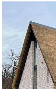
Strakke vormgeving kap
