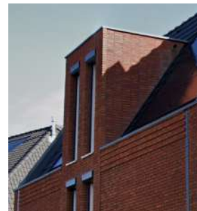
Dakkapel met minimaal lijstwerk
