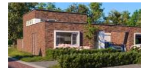
Hoogte aan de achterkant van de woning
