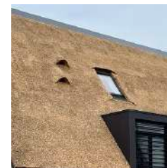
Strak rieten dak
