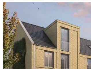
Dakkapel met minimaal lijstwerk
