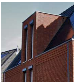
Dakkapel met minimaal lijstwerk
