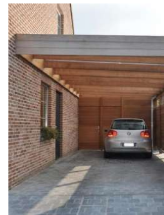
Pergola aan voorzijde van woning
