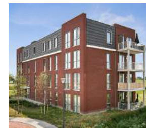
Bovenste verdieping als dakprofiel uitgevoerd
