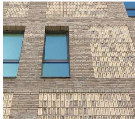
Verfijning en accenten in metselwerk
