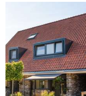
Rode daken zonder zonnepanelen in het zicht.
