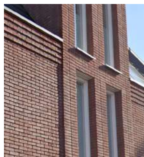
Detailing en diepte in metselwerk
