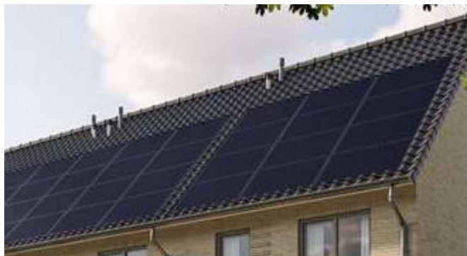
Antraciete, matte pannen en PV-panelen in regelmatige vlakken
