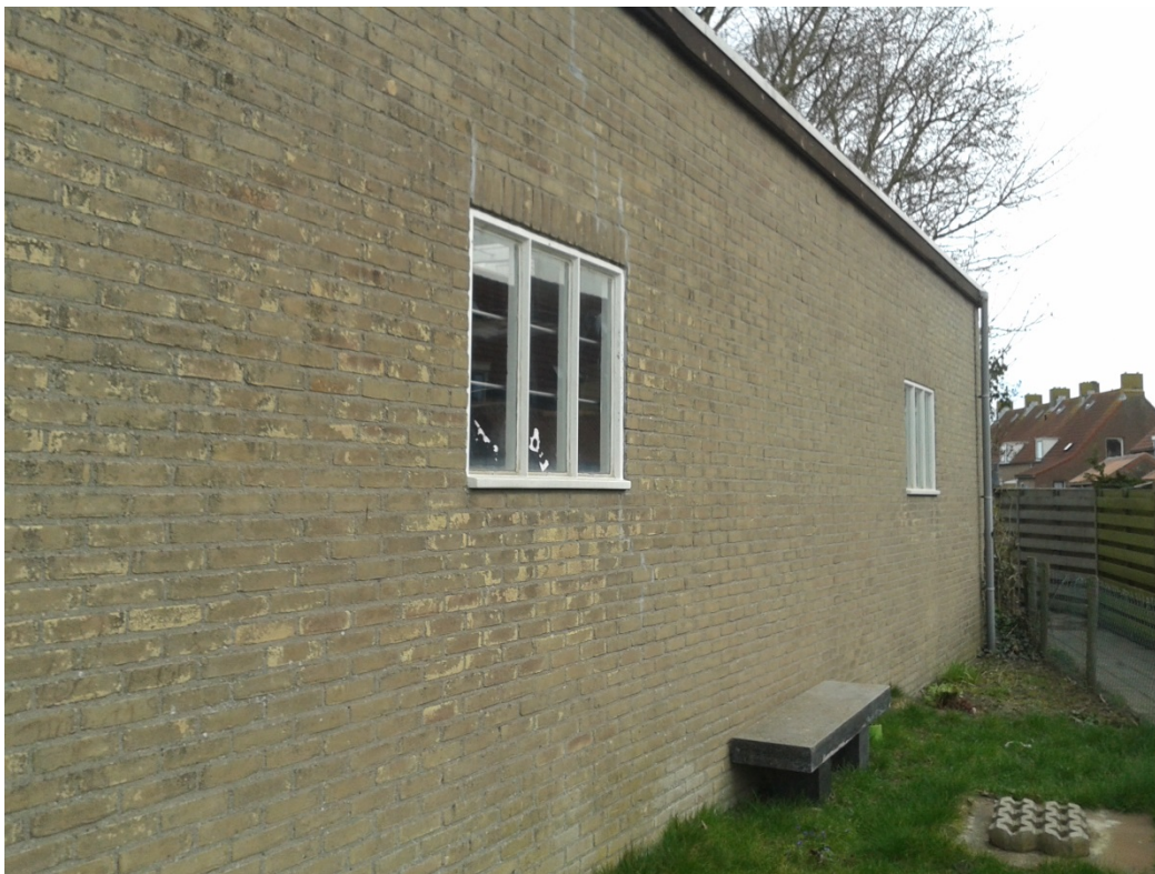
Figuur 3: daklijsten, bevestigingen van regenpijpen en kieren langs vensterbanken worden in de praktijk vaak als invliegopening gebruikt.
