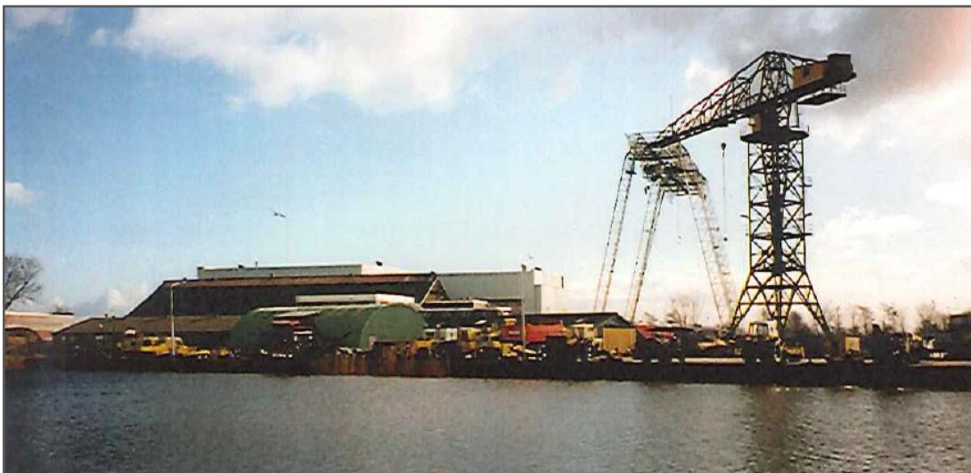
Foto 7: Aanzicht van de scheepswerf met de afbouwkade gezien vanuit de werkhaven. De torenkraan en portaalkraan zijn prominent aanwezig.
