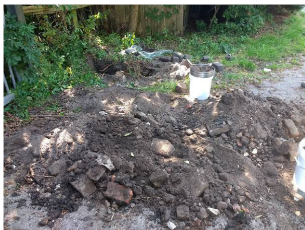
Foto 4: Onderzoekslocatie, gezien in westelijke richting
