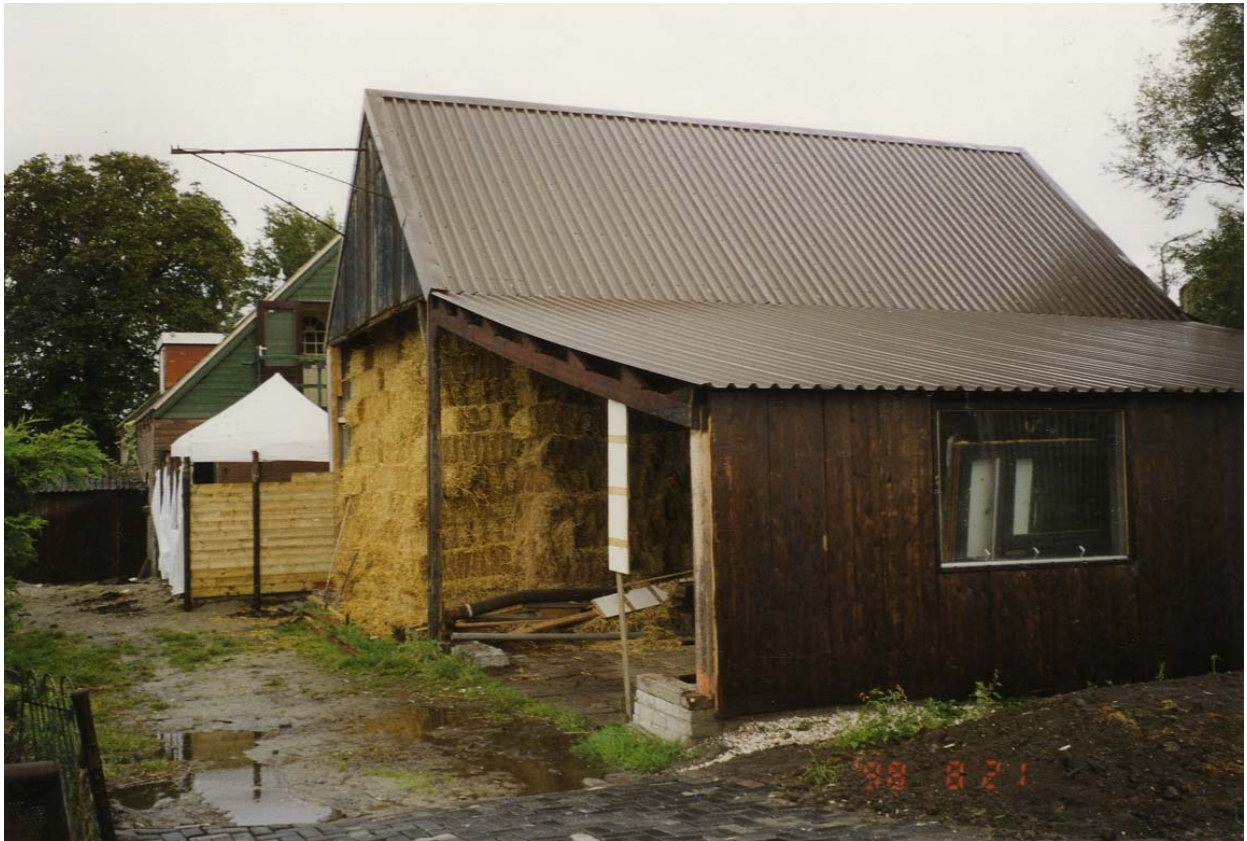
Foto behorend bij de bouwvergunning uit 1999 (Westeinderweg 2)
