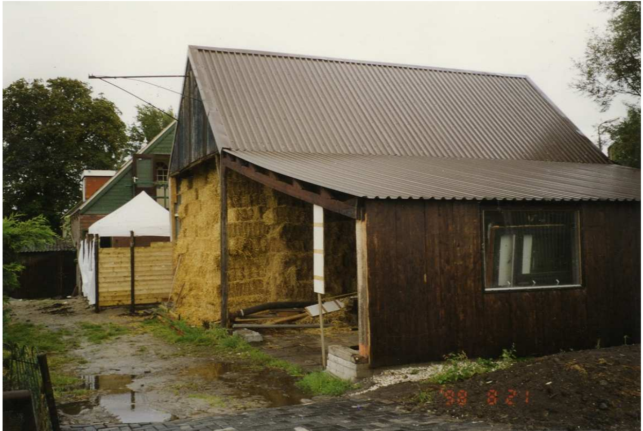
Foto behorend bij de bouwvergunning uit 1999 (Westeinderweg 2)
