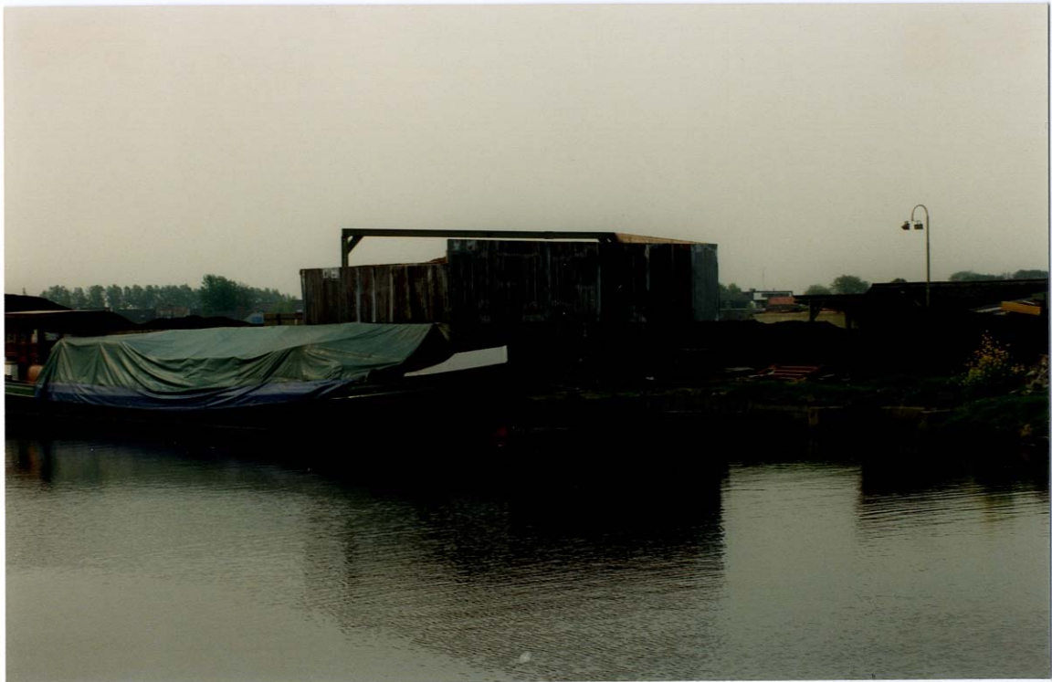
foto's behorend bij de bouwvergunning uit 1990; Westeinderweg 2b.
