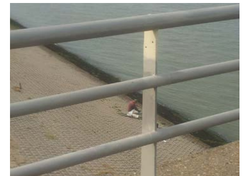
Wit hekwerk bestaande uit ronde kokers met slanke verticale elementen. (fietsbrug Den Haag).
