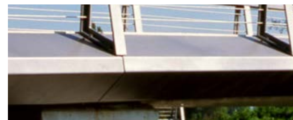
Verjongen brugdek. Brugrails weggewerkt en in zelfde vormen taal (Noord Oost Poort Apeldoorn).
