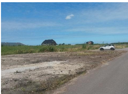
Foto 5. Gezien vanaf de Doctor van Noortstraat welke de verbindingsweg zal kruisen evenals de Nieuwe Vaart welke is gelegen aan de linkerzijde. Gezien de hoge ligging is de vaart op de foto niet zichtbaar. Aan de kale vlakte is te zien dat de sloopwerkzaamheden reeds zijn uitgevoerd
