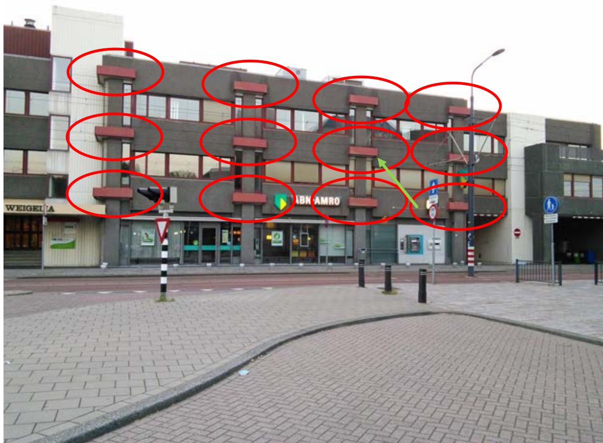
Figuur 4-4: structuren van het gebouw die kunnen fungeren als verblijfplaats (zie rode cirkel). Op het gehele kantoorgebouw komen deze voor, en in potentie kunnen ze allemaal dienen als verblijfplaats. De groene pijl geeft een invliegplaats weer waar invliegende gewone dwergvleermuizen zijn waargenomen.
