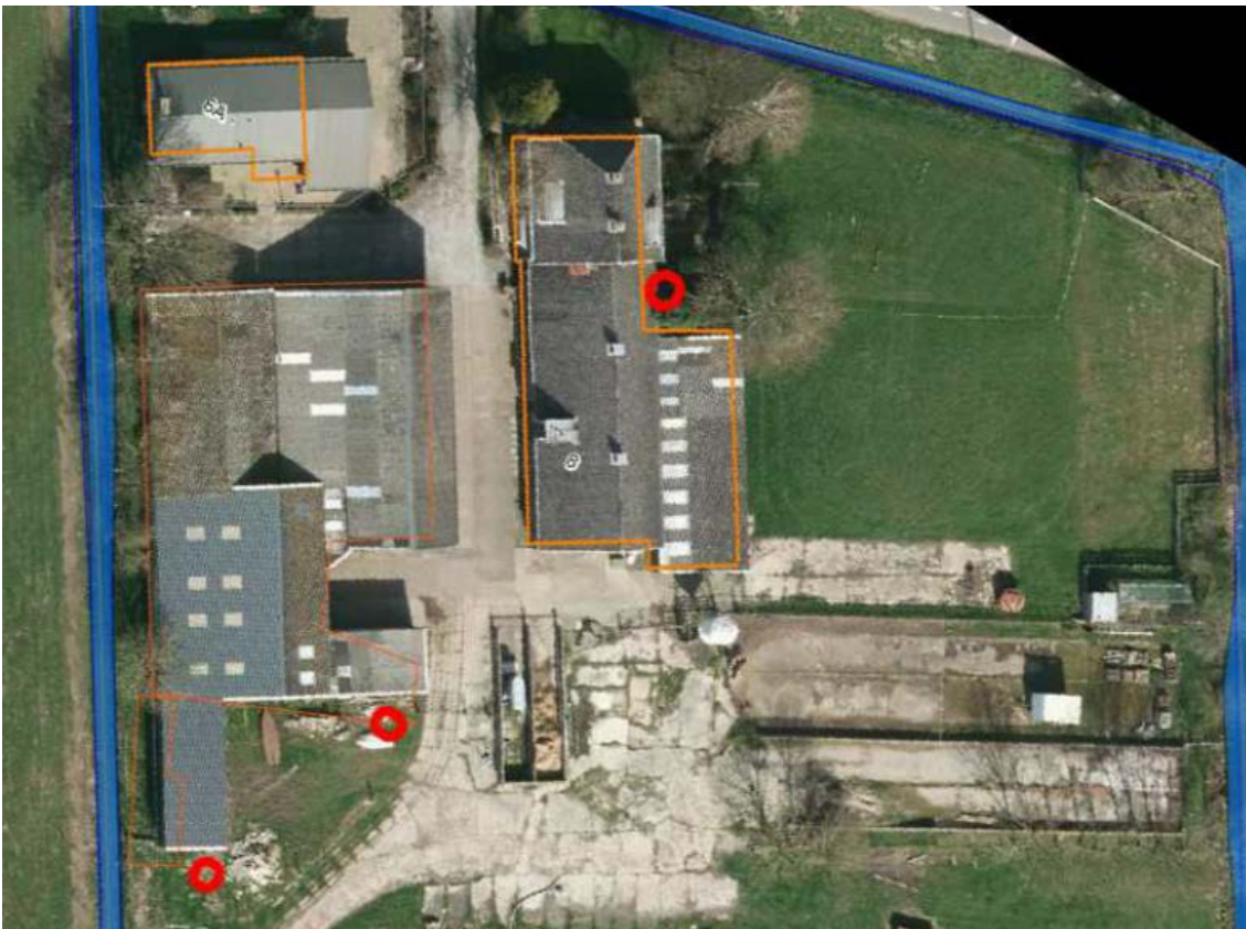
Afbeelding 3 Ligging voormalige opslagtanks (gemarkeerd met rode cirkels), overgenomen uit rapport historisch onderzoek
