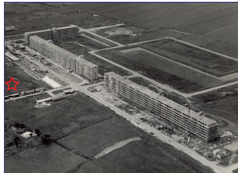
Afbeelding 6b / wijk De Prinsenhof in aanbouw
