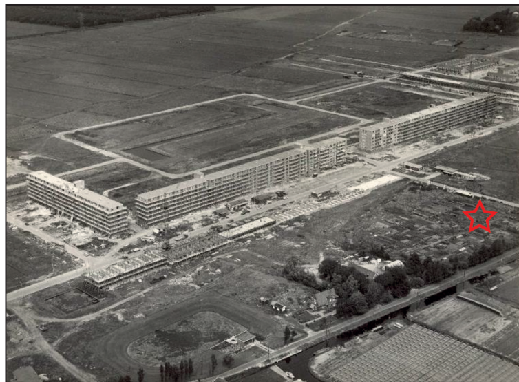
Afbeelding 6a / wijk De Prinsenhof in aanbouw
