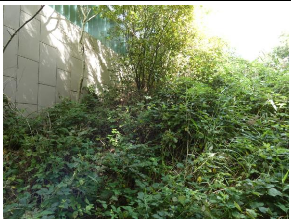
Foto 1 grondwal tegen de gevel van Nieuwstraat 2-2A
