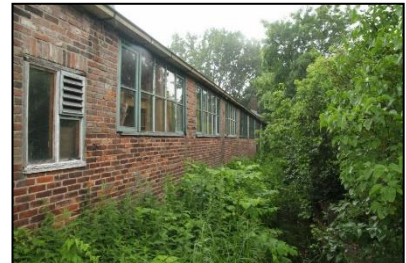
Figuur 5. Westelijke gevel van de geschakelde loodsen.
