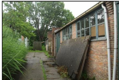
Figuur 4. Oostelijke gevel van de geschakelde loodsen.
