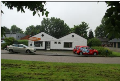
Figuur 3. Noordelijke gevel van de geschakelde loodsen.
