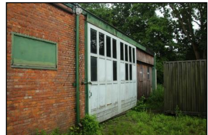
Figuur 8. Westelijke gevel van de losstaande loods.
