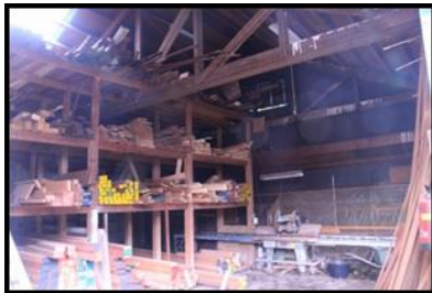
Figuur 9. Zuidelijke binnenkant van de losstaande loods.
