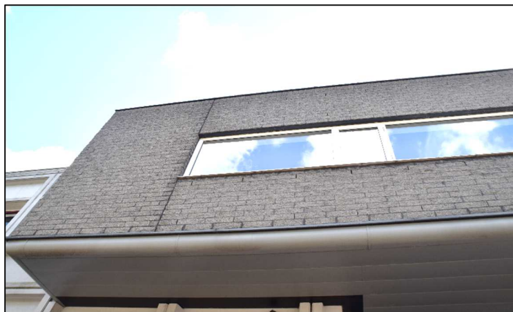
Vlietweg 15: stootvoegen in gemetselde muur.
