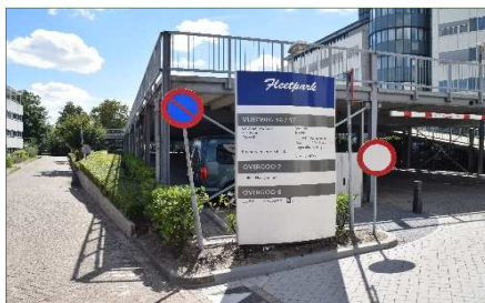
Parkeergarage van ijzer.
