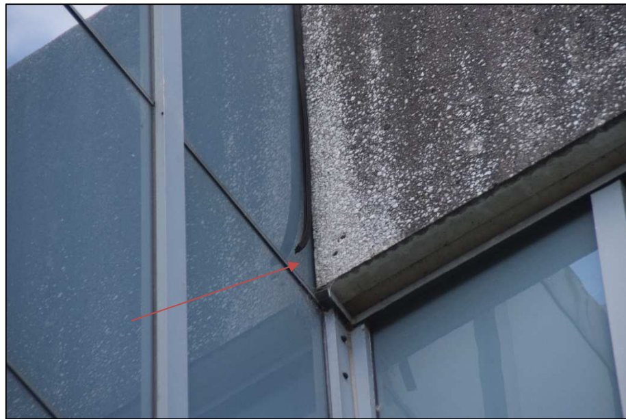
Kier die mogelijk toegang geeft tot ruimten voor vleermuizen.
