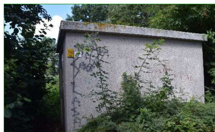
Electriciteitshuisje (nabij Overgoo 11).
