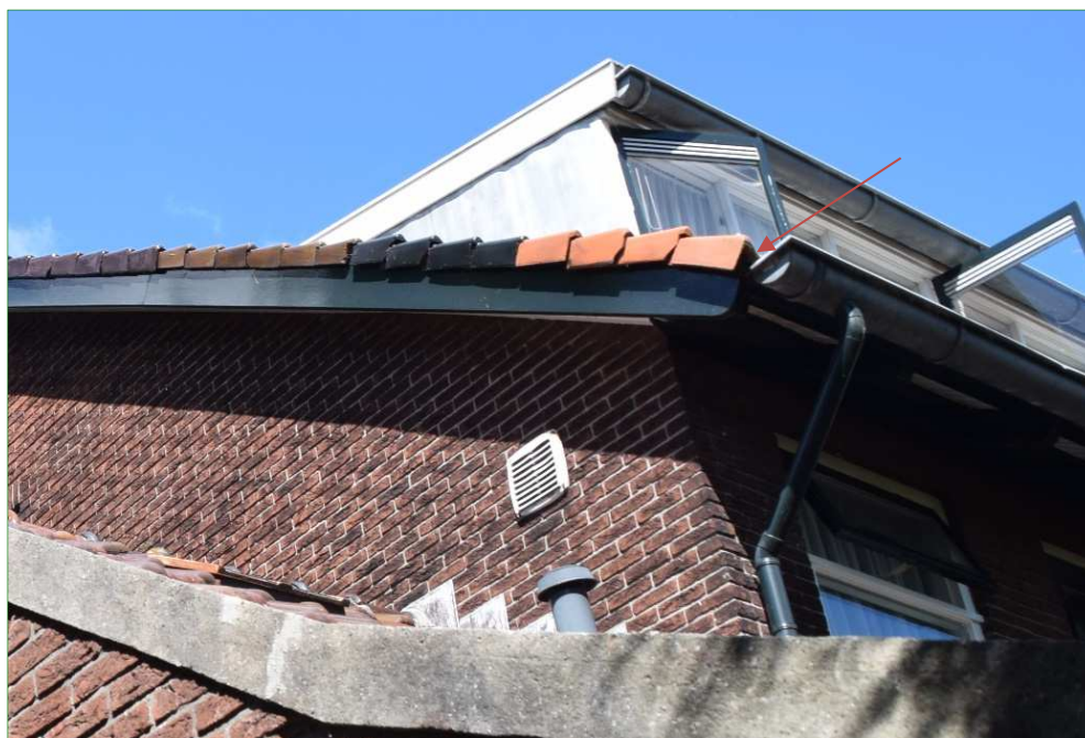
Openingen onder dakpannen geven toegang tot ruimten voor Huismus.
