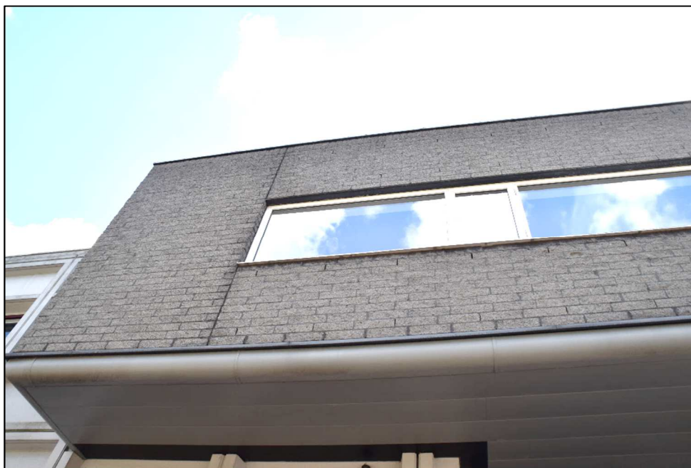
Stootvoegen geven mogelijk toegang tot ruimten voor vleermuizen (Vlietweg 15).
