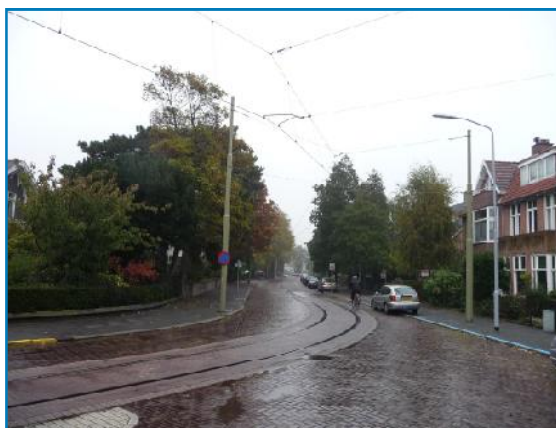
Foto 3. Westeinde. Bomen ruimtelijk conflict met bovenleiding tram.
