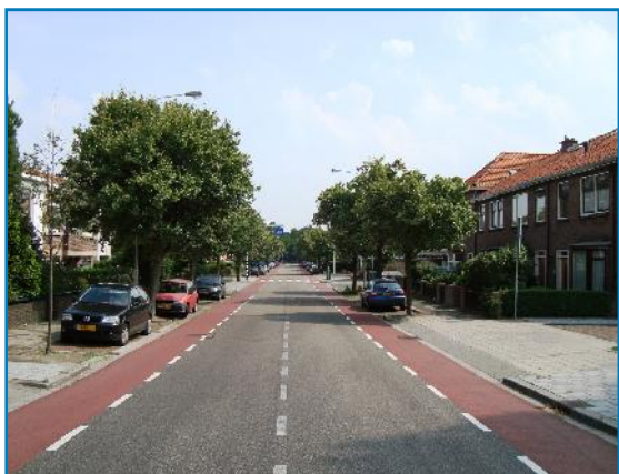
Foto 3. Overlast omdat boomwortels verharding opdrukken.
