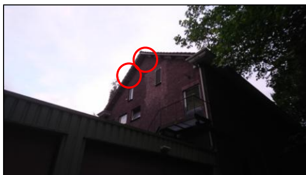
Foto 1: Zomer- en paarverblijf gebouw 185n
