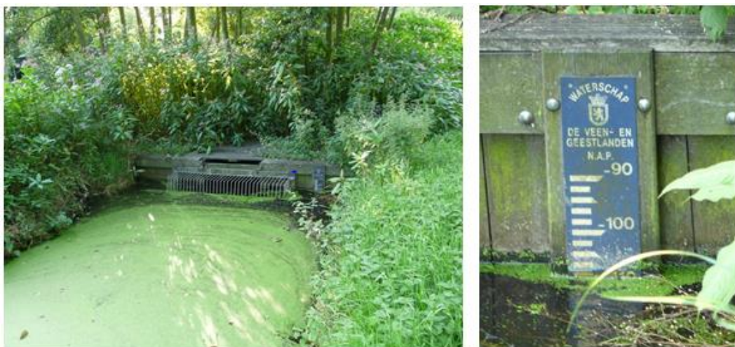
Figuur 2-7: De afvoer vanuit het poldergebied vindt plaats via een stuw en sifon
