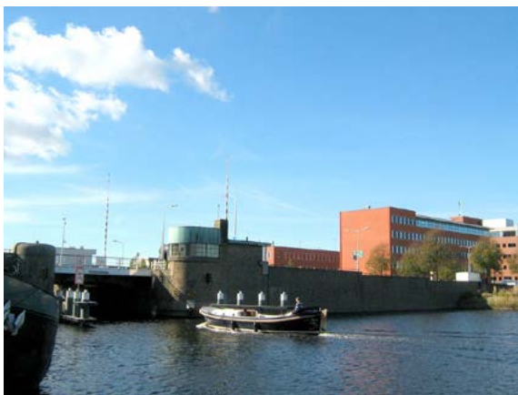
Figuur 61: foto van de Binckhorstbrug
