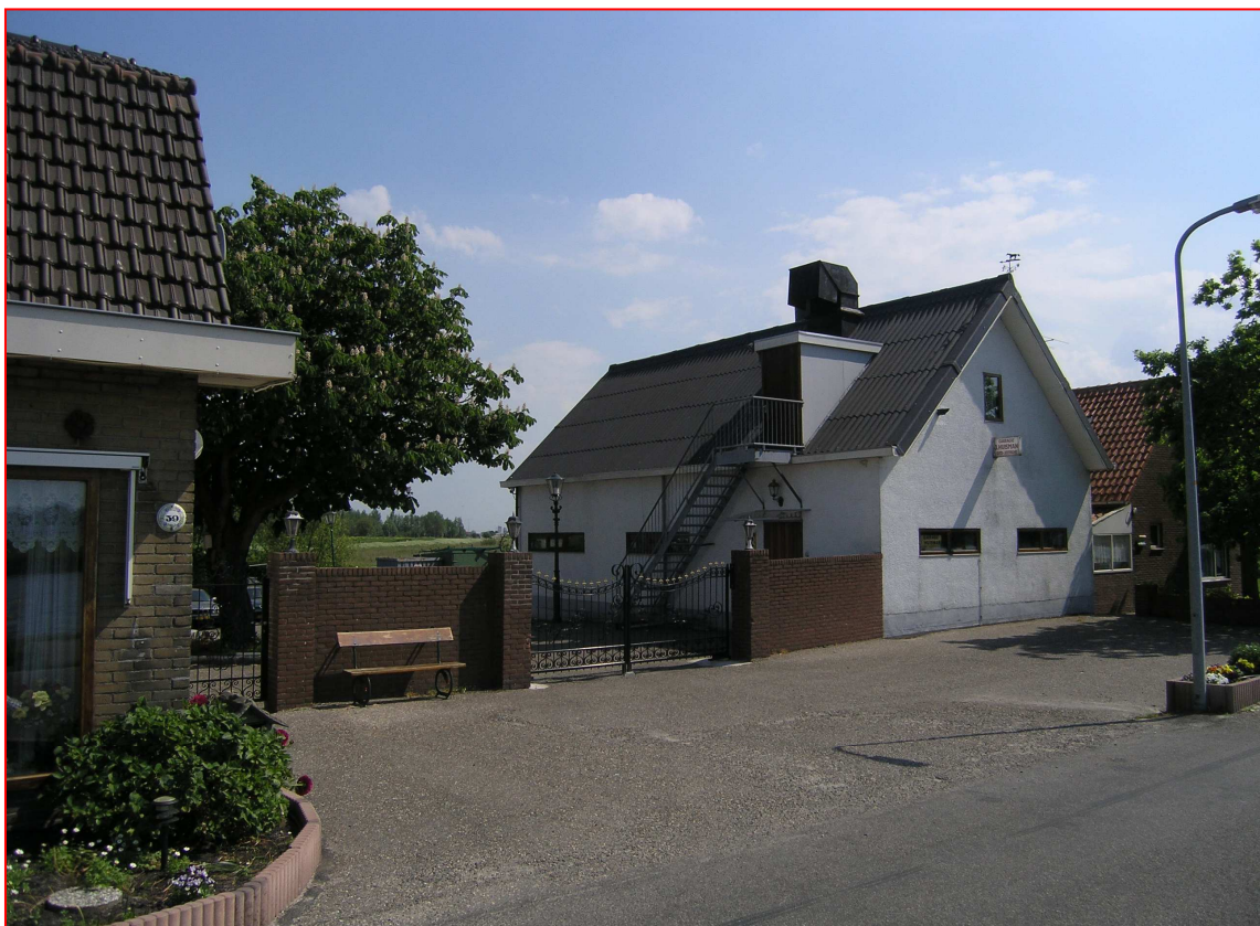
Foto mei 2008: woning (links) met de garage (rechts).
