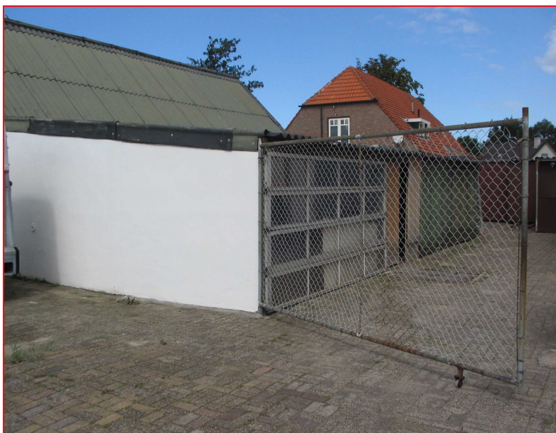
Foto op 29 augustus 2007 De achterkant van het terrein is niet vanaf de weg waar te nemen (foto 2 en 3 op deze pagina)
