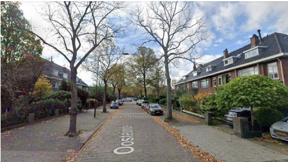
brede horizontale gevels langs het Oostende
