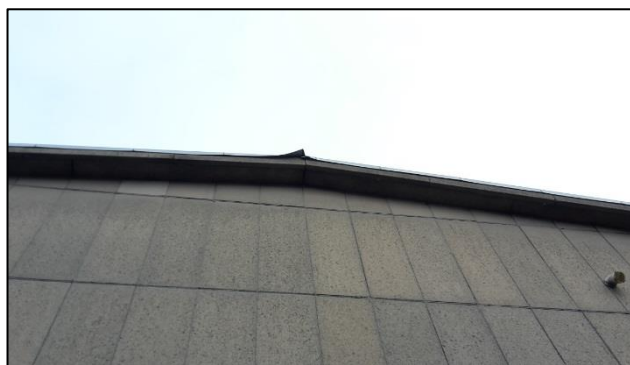
Foto 24: Ruimte achter daklijst, geschikt voor vleermuizen.
