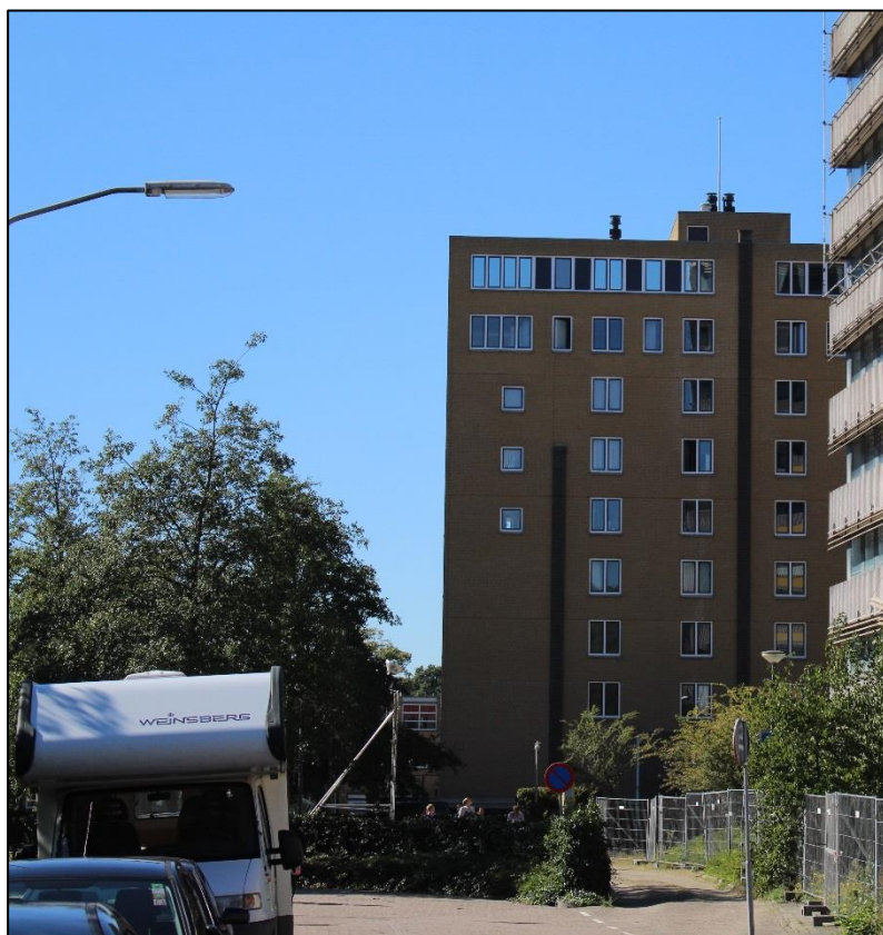
Afbeelding 6: Eén van de appartementencomplexen langs de Johan David Zocherstraat
