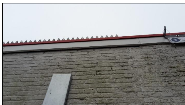
Foto 2: Ruimte achter daklijst, geschikt voor vleermuizen.
