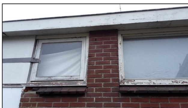
Foto 15: Open stootvoegen, geschikt voor vleermuizen.
