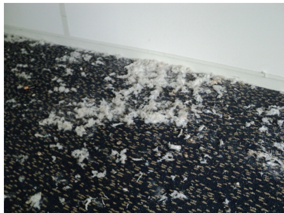
De uitwerpselen en donsveren van een duif in het kantoor op de 3 e verdieping.
