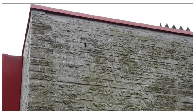
Foto 3: Open stootvoegen, geschikt voor vleermuizen.
