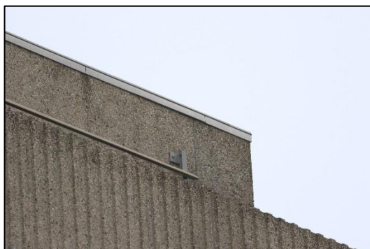
Foto 7: Ruimte achter daklijst, geschikt voor vleermuizen.
