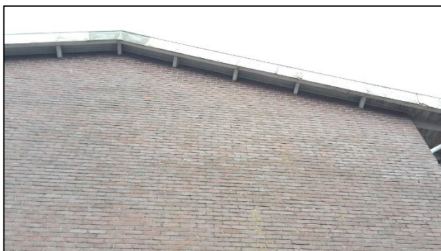
Foto 25: Open stootvoegen, geschikt voor vleermuizen.
