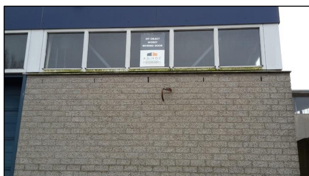
Foto 16: Open stootvoegen, geschikt voor vleermuizen.
