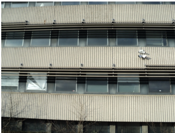
De gevels zijn afgewerkt met betonnen platen zonder open stootvoegen.
