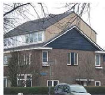
de nokverhoging links is goed gematerialiseerd, rechts is baksteen toegepast voor de zijkant, boven een topgevel die al was afgerond in hout. Het resultaat oogt onevenwichtig en voldoet welstandshalve niet voor wat betreft de materialisering.
