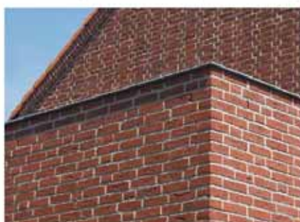
goede detaillering, met een zinken kraalrand in plaats van een boeiboord of dakoverstek, de regenpijp is in de spouwmuur opgenomen.
