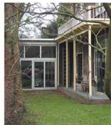
deze aanbouw is licht vergunningplichtig, is immers dieper dan 250cm vanaf de zijgevel en. De platte kozijnprofilering is niet in overeenstemming met de architectuur van het hoofdgebouw, voldoet niet aan redelijke eisen van welstand
