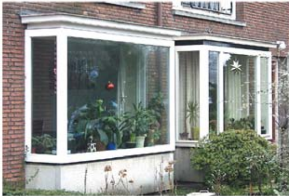
de linker erker mist de indeling en de zwarte rand van het origineel dat nog rechts te zien is, voldoet niet aan redelijke eisen van welstand
