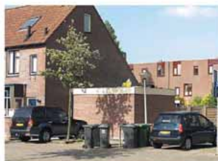
voldoet niet, te gesloten aanbouw
