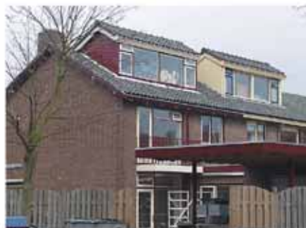
dakopbouwen met verschoven nokverhoging, de rechter opbouw is iets te hoog waardoor een borstweringstrook is toegepast die de opbouw teveel een "doos" karakter geeft.
