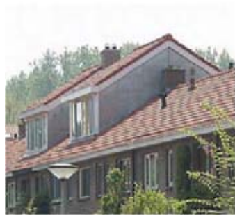
de nokverhoging links is goed gematerialiseerd, rechts is baksteen toegepast voor de zijkant, boven een topgevel die al was afgerond in hout. Het resultaat oogt onevenwichtig en voldoet welstandshalve niet voor wat betreft de materialisering.
