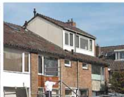
dakopbouwen met verschoven nokverhoging, de rechter opbouw is iets te hoog waardoor een borstweringstrook is toegepast die de opbouw teveel een "doos" karakter geeft.
