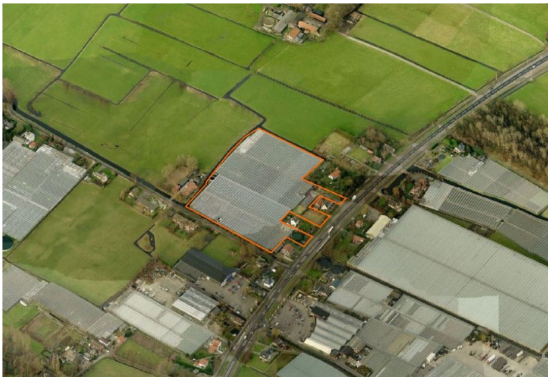
Fig. 1.1 Luchtfoto planlocatie, met projectlocatie (oranje omkaderd)
