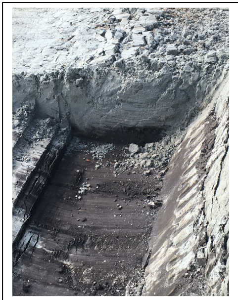
Gegraven gat ter plaatse van de verwijderde betonverharding
