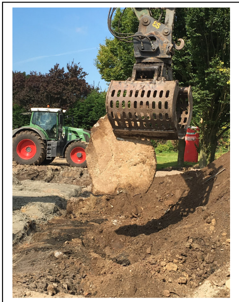
Verwijderen van beton langs de betonverharding.
