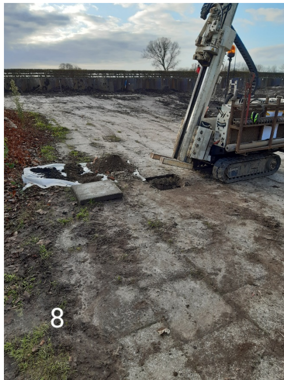
Inspectie IG08 (en boorstelling)
