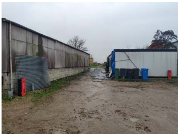
Noordzijde, vanaf toegang richting west
