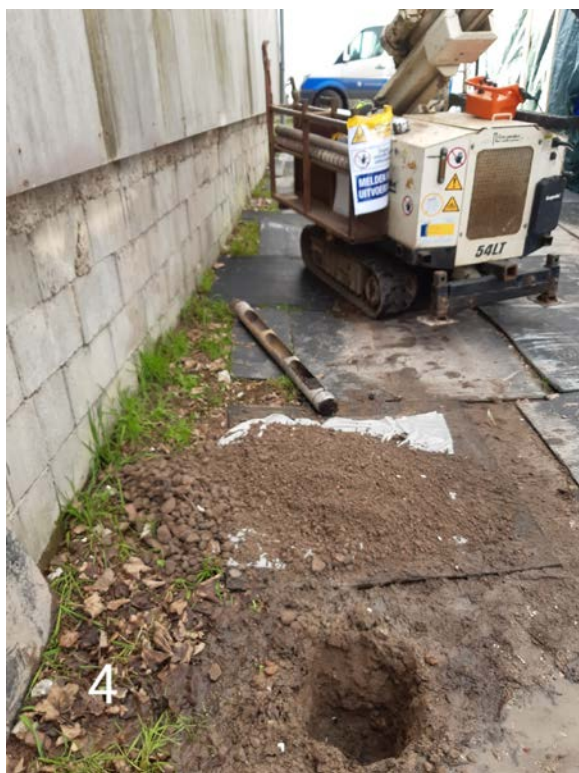
Inspectiegat IG04 (en boorstelling)
