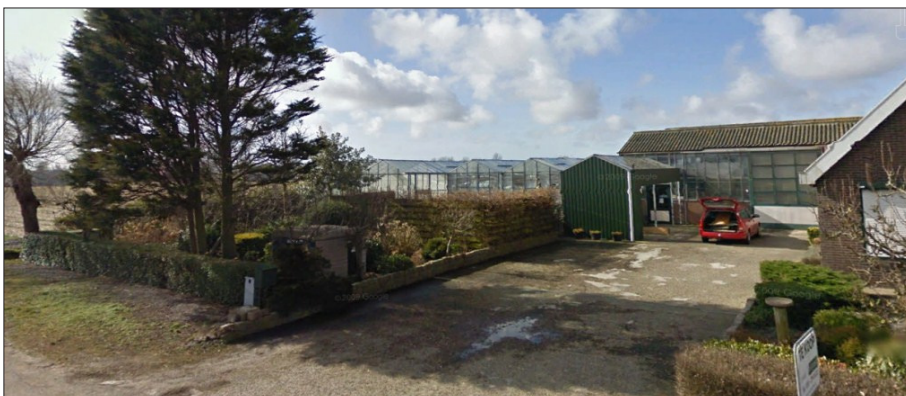
Figuur 2. Huidige (bedrijfs)gebouwen en bedrijfswoning
