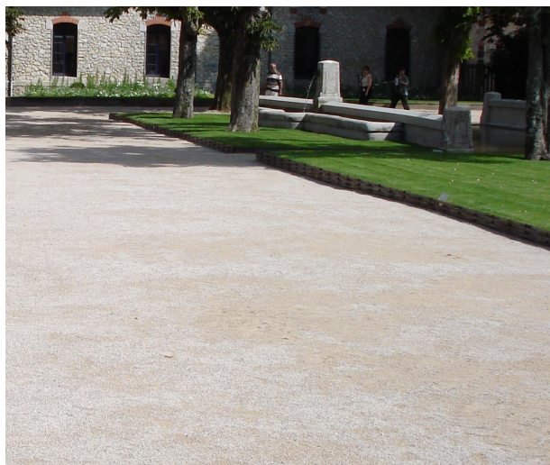
Referentie, oprit van halfverharding
