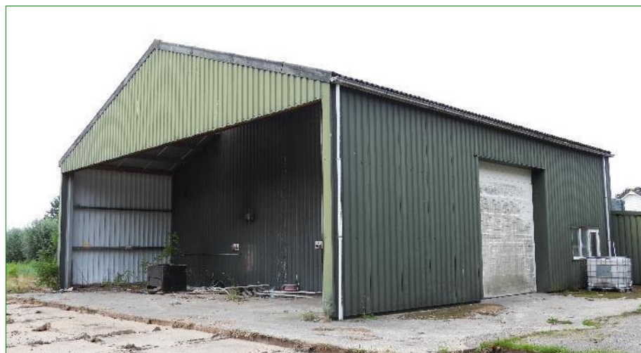
De te slopen schuur in het plangebied.
