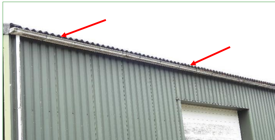
De openingen onder de golfplaten (rode pijl) van de te slopen schuur geven mogelijk toegang tot voor Huismussen geschikte achterliggende ruimtes.
