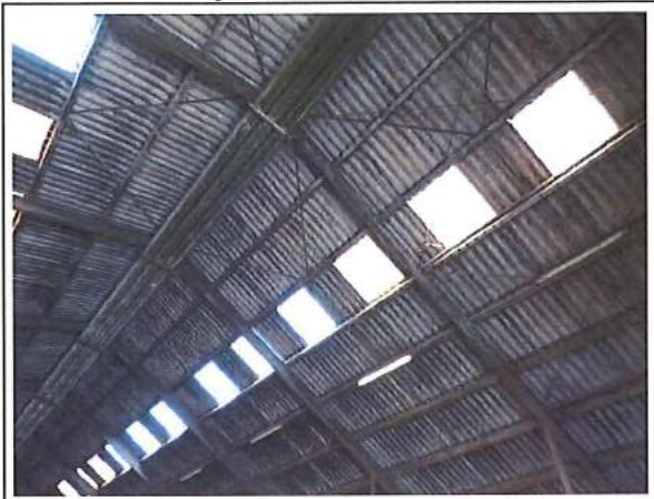
Foto 13: binnenzijde dak koeienstal
