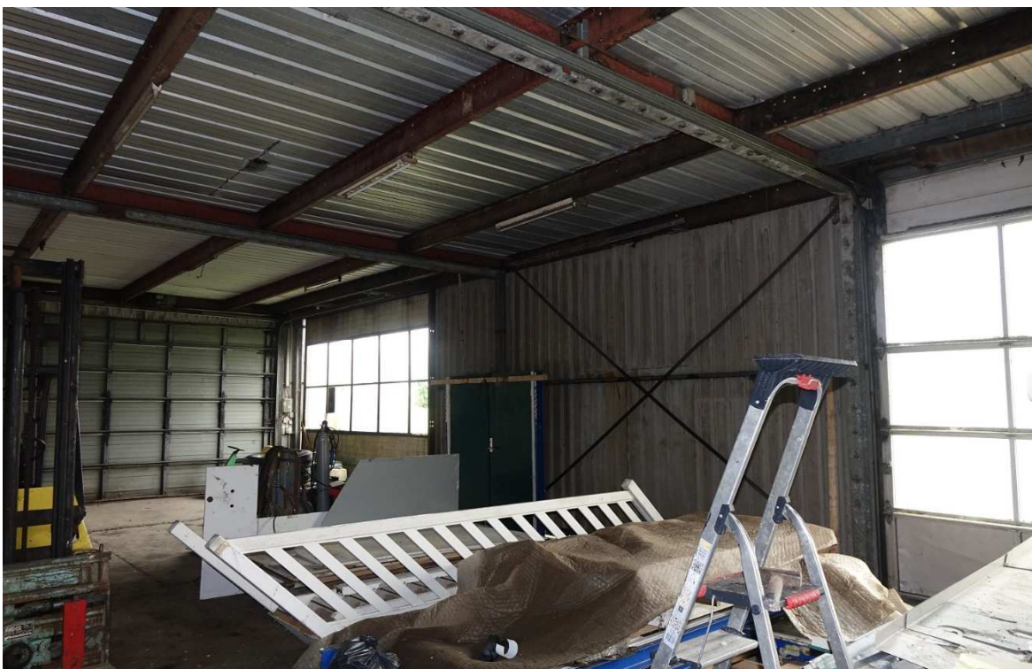
Figuur 2. Interne situatie van de aangebouwde loods aan de Schelpenbolweg 16
