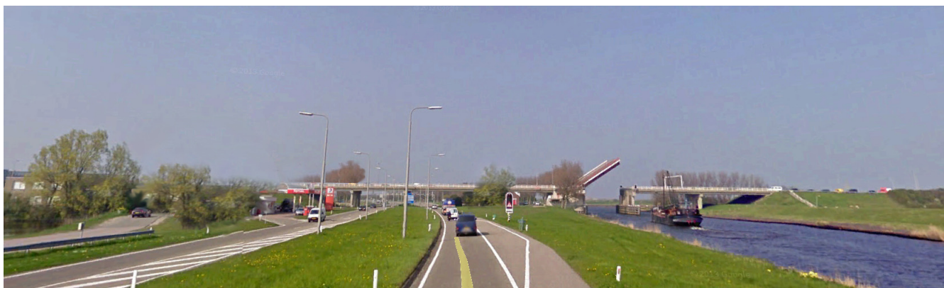
Verbetering van zicht onder brug en viaduct door aanpassing in beplanting
