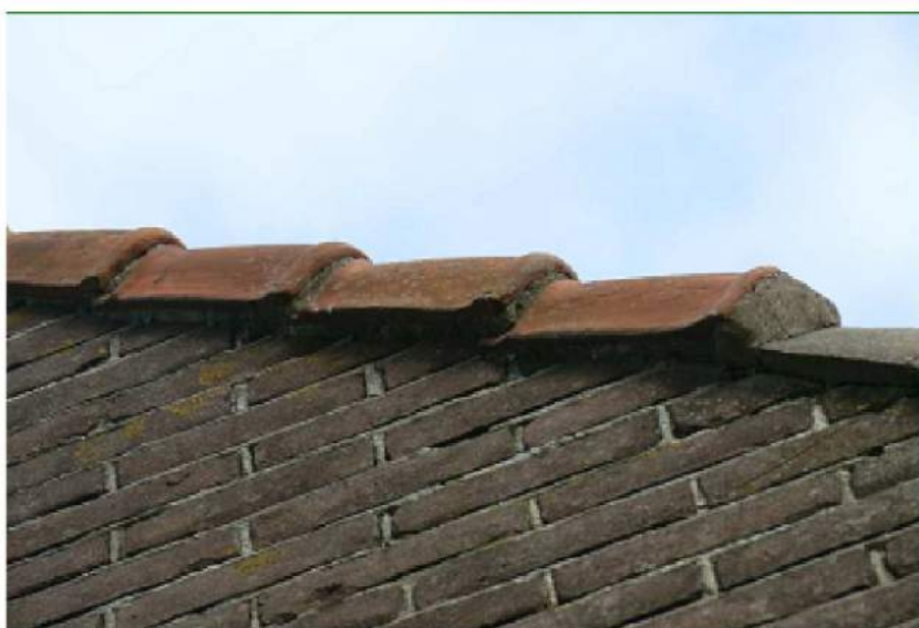
De spleten onder overhangende dakpannen zijn dichtgemetseld.
