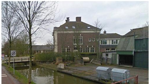
Afb. 6 Herenhuis ten westen van het voormalige bedrijf
