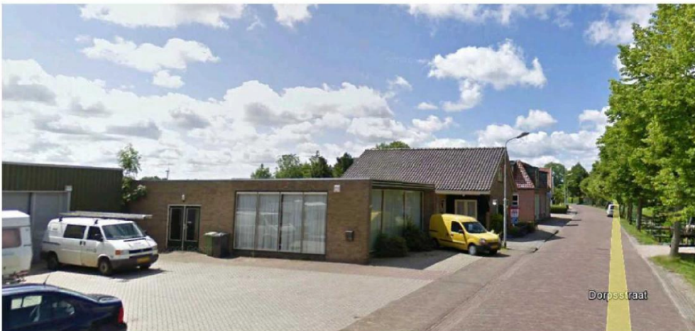
afb. 3 Bestaande bebouwing op de planlocatie met de showroom en links de opslagloods
