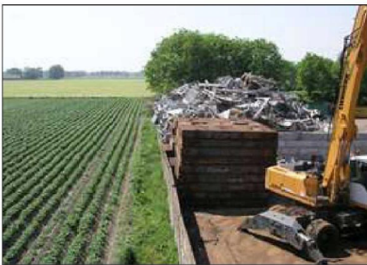
Figuur 8 en 9. Schutting achterzijde erf
