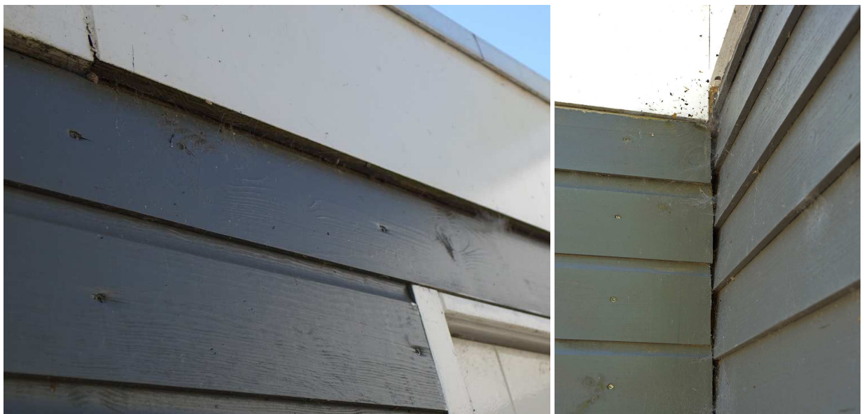
Figuur 5. Dakranden ontoegankelijk voor vleermuizen en eventuele kieren bezet met spinrag
