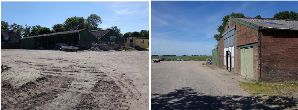
Figuur 3. De aanwezige bebouwing op het erf aan de Noord Zijperweg 1 te Wieringerwaard
